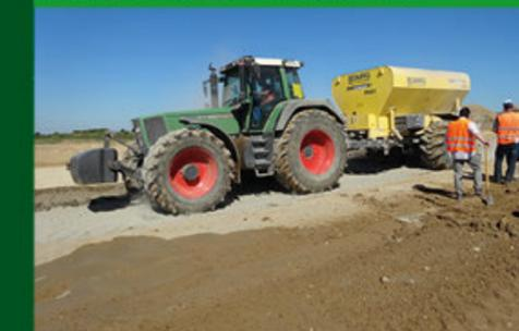
Zur Errichtung des aktuellen Basisabdichtungsabschnitts Haltung 7 wurde der örtlich anstehende Geschiebelehm mit Tonmehl derart vergütet, dass ein hochwertiges mineralisches Dichtungsmaterial erzeugt wird, welches die laut Genehmigung geforderten Qualitätsanforderungen erfüllt. Durch die Substitution von Tonen durch in situ hergestellte mineralische Dichtungen werden künftige Transport- und Materialkosten gespart, wertvolle Ressourcen werden durch Verwendung der anstehenden Böden geschont.
