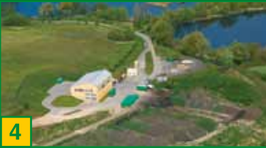
Umschlagstation Freidorf Lose Verladung mit 6 Containerstellplätzen
