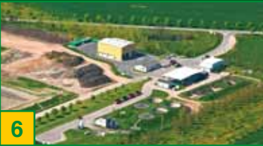
Umschlagstation Stern Lose Verladung mit 2 Container- stellplätzen und Flachbunkerbereich
