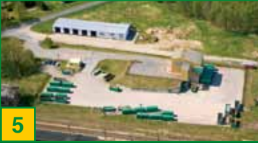
Umschlagstation Jatznick Stopfpresse mit Räumschieber
