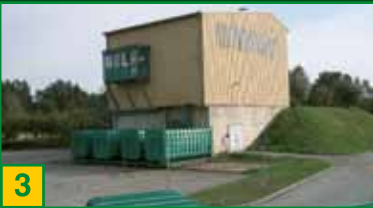
Umschlagstation Neustrelitz Stopfpresse und Stellplatz für lose Verladung
