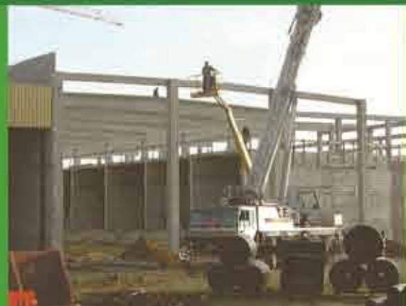
9 Setzen der Stahlbetonbinder der Tunnelfüllhalle
