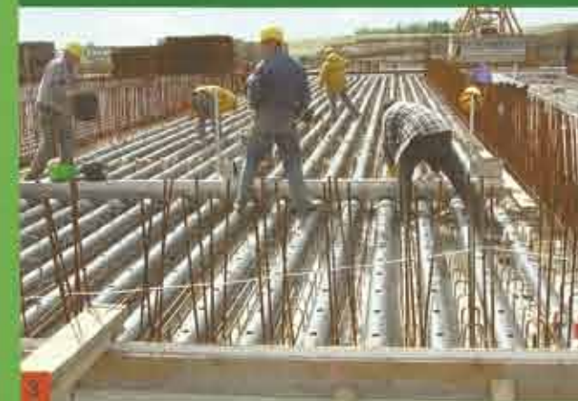
3 Einbau Belüftungssystem Intensivrotte
