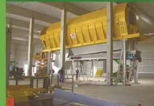
5 Montagebeginn der Siebtrommel, Aufbereitungshalle 30.7.2004
