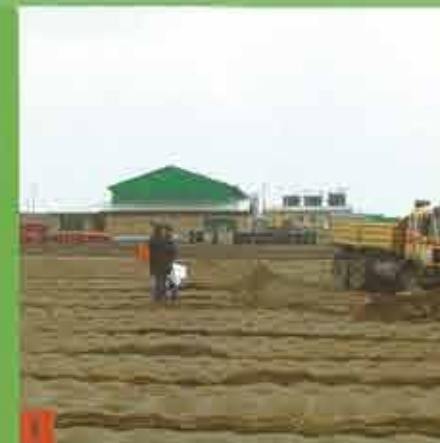
1 Profilierungsarbeiten Baufeld ABA im Februar 2004
