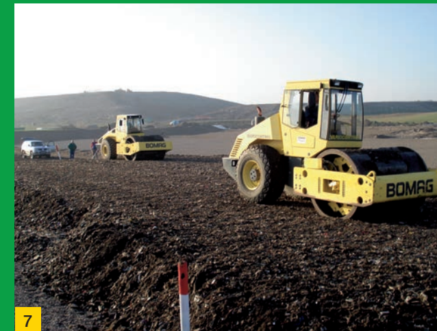
7 Abfalleinbau MBA Rottegut
