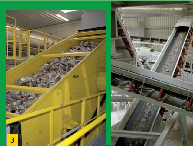
3 Qualitätsverbesserung der HWR-Fraktion (heizwertreiche Fraktion) – Einbau einer zusätzlichen Vibrations- siebanlage
