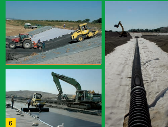
6 Errichtung Nordpolder der Abfallentsorgungsanlage Rosenow
