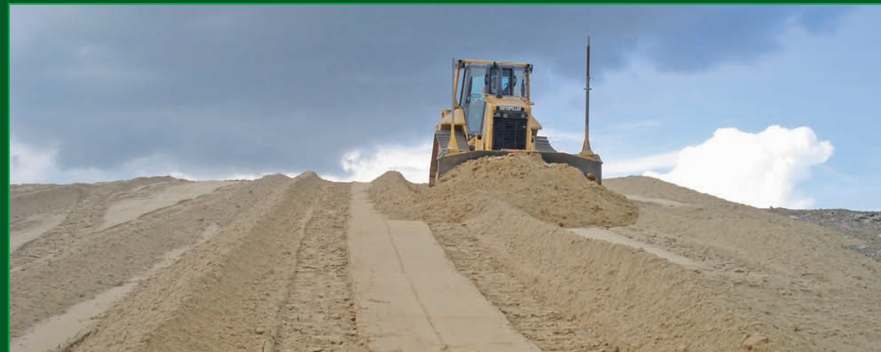
Einbau gasgängige Ausgleichsschicht
