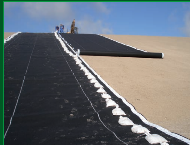
Verlegung Kunststoffdichtungsbahn
