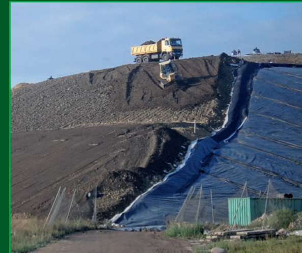
Einbau Wasserhaushaltsschicht
