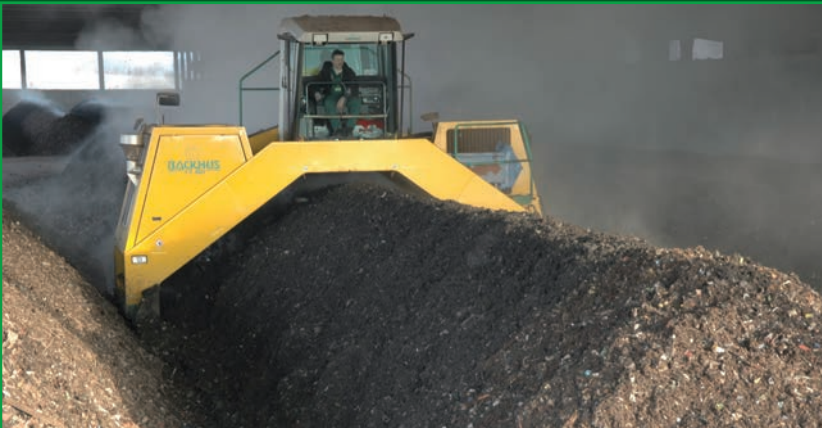
Umsetzer in der Nachrotte. Das Konzentrat der Sickerwasserreinigung wird zur Befeuchtung des ablagerungsfähigen Rottegutes eingesetzt.
