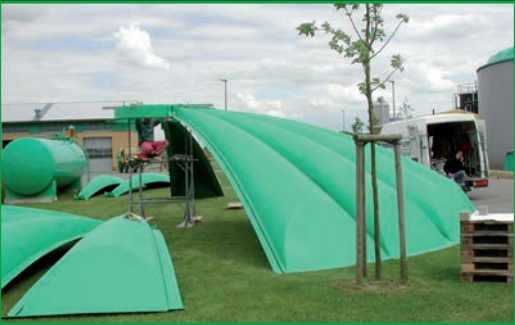
Errichtung Rohsickerwasserspeicher
