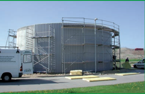
Errichtung Rohsickerwasserspeicher
