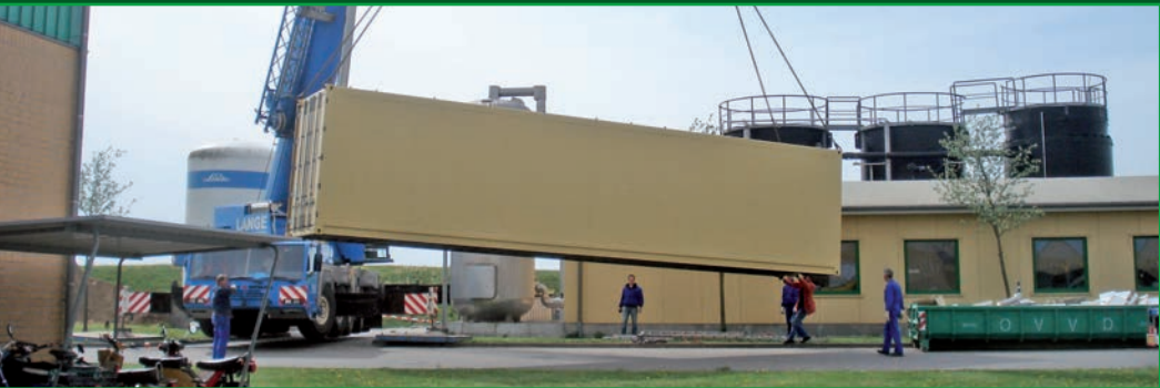
Montage Umkehrosmoseanlage (Containerbauweise)
